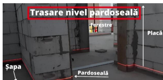
Fig. 34. Trasarea pardoselii cu nivela laser
