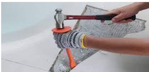
Fig. 65. Remedierea defectelor pardoselii
